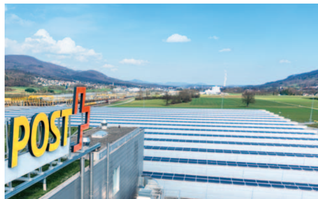
Nei suoi impianti fotovoltaici, la Posta produce energia solare per il proprio fabbisogno. L'eccedenza sarà immessa nella rete pubblica.
